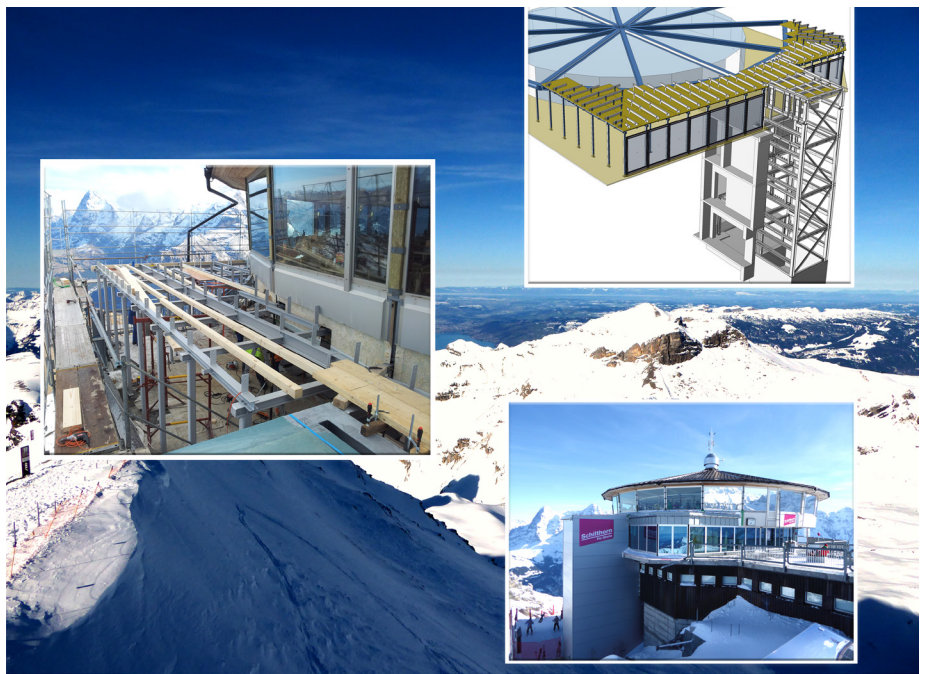
Avec une vue spectaculaire sur la Swiss Skyline, les façades et toitures du restaurant Piz Gloria à Schilthorn ont été refaites (Image: Stauffer Metallbau AG)
